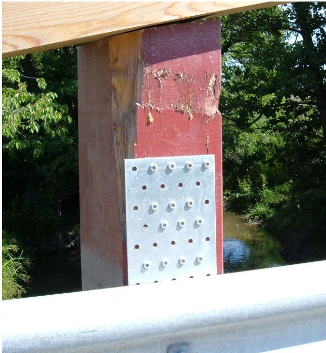
Fig 9. Skada 6, avkapade och skarvade ståndare, bild från 2008.
