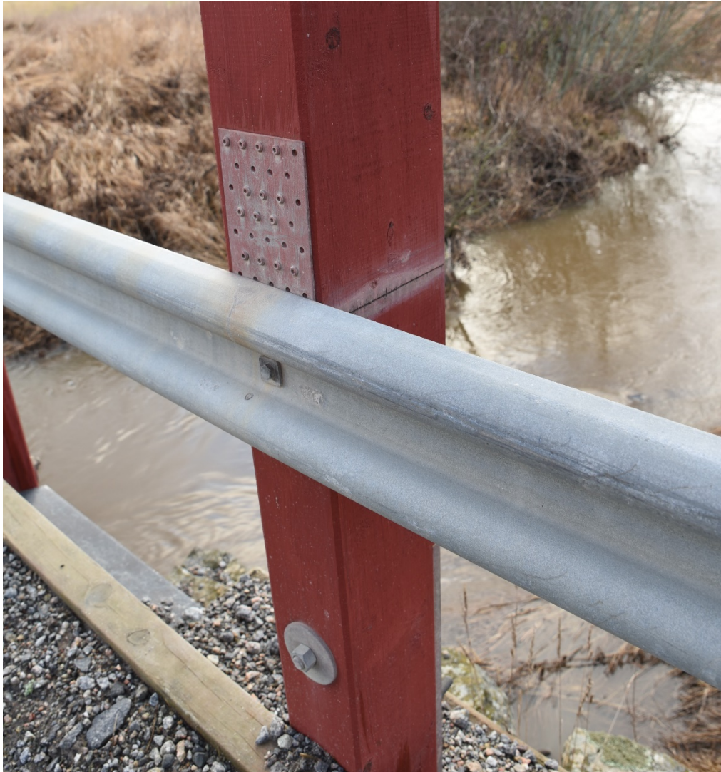
Fig 8. Skada 6, avkapade och skarvade ståndare, bild från 2020.
