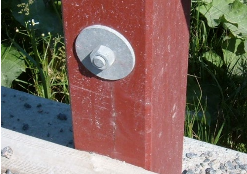
Fig. 1. Skada 1, är en naturlig mörkspäckning, bild från 2008.
