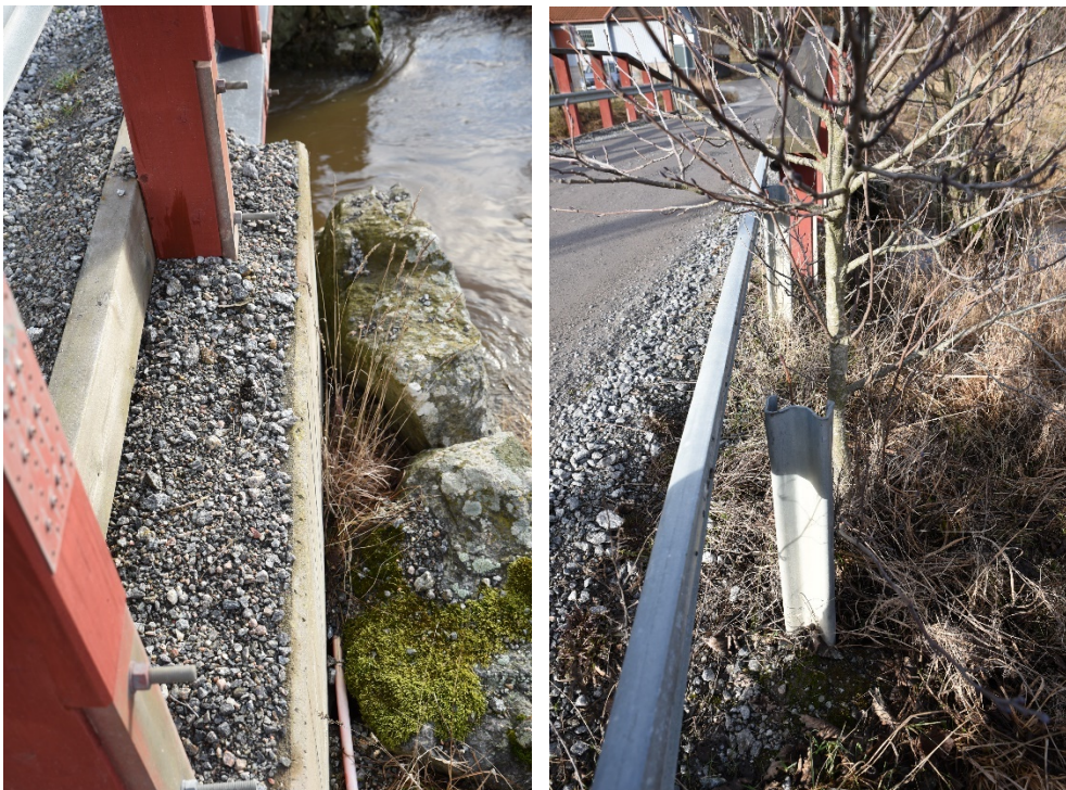
Fig 9. Skada 9, Att sopa, spola eller blåsa bort grus och klippa sly är enkelt och billigt underhåll som betalar sig väl sett över tid.
