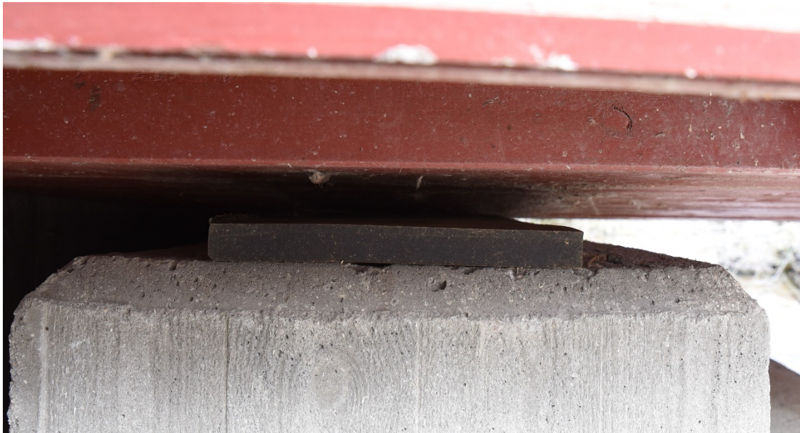
Fig 10. Skada 7, I SV hörn är glappet drygt 30mm.
